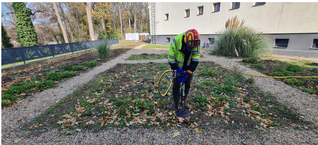
Fig. 7 - Exemplificare referitoare la compactarea solului prin injectarea substratului cu aer comprimat
