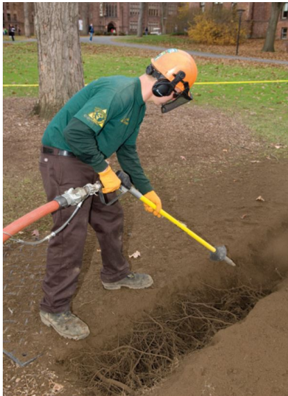
Fig. 12 - Exemplificare referitoare la utilizarea sistemelor de tip AirSpade pentru intervenții în Zona de Protecție a Arborelui (ZPA) pe parcursul lucrărilor de amenajare: (stânga) excavarea sistemului radicular fără afectarea rădăcinilor arborelui prin rupere sau tăiere; (dreapta) acoperirea rădăcinilor după finalizarea intervențiilor punctuale
